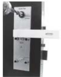
图 19 用 13mm 钻头分别在 门两侧钻内外模块 连接线过孔。
