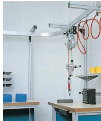
Compressed air tools การติดตั้งระบบเครื่องมือลมภายในโรงงาน
